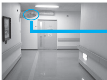
衝突防止ミラーの設置：1階廊下
