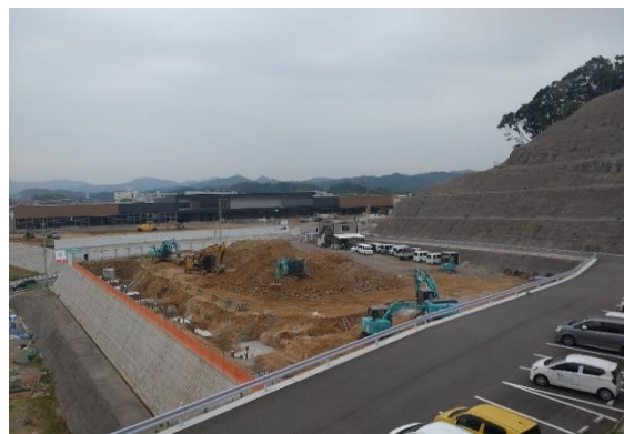
基礎工事：根伐、地業（2023.6.14撮影）
