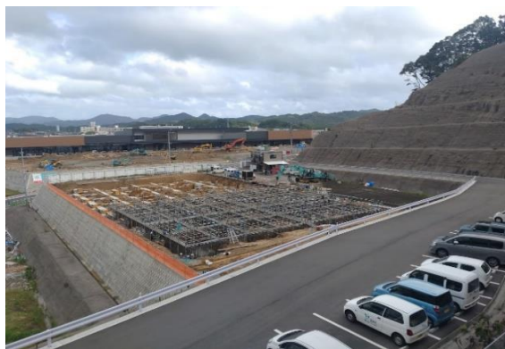
鉄筋工事：基礎配筋（2023.7.12撮影）
