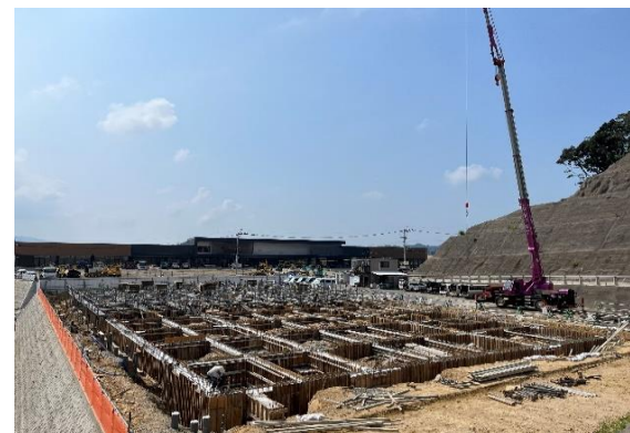
鉄筋工事：基礎配筋（2023.7.29撮影）
